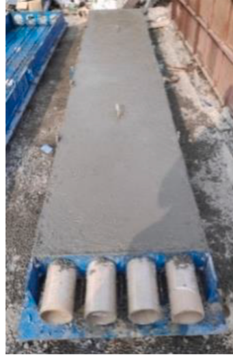
Figura 4 – Laje com alvéolos criados por canos de PVC.
